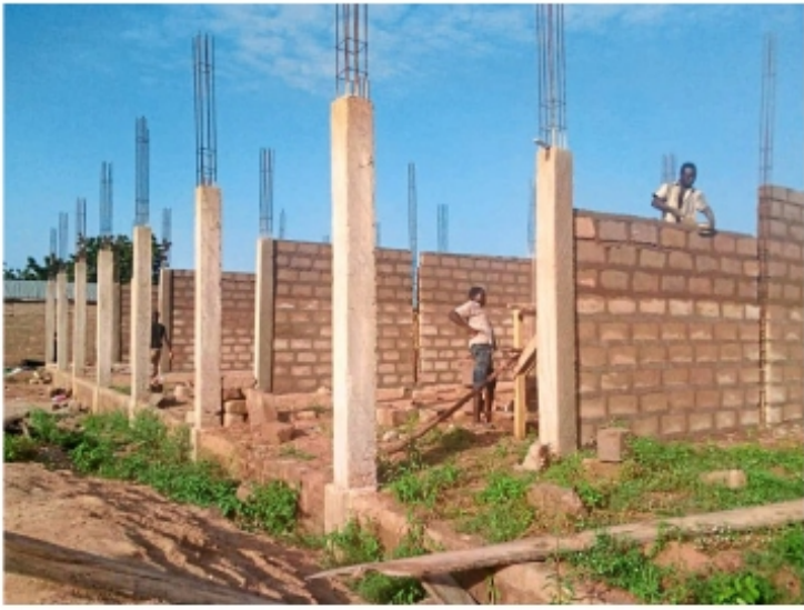
2017: Die Bauarbeiten beginnen.
